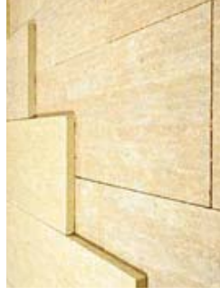
Схема укладки утеплителя в 2 слоя
